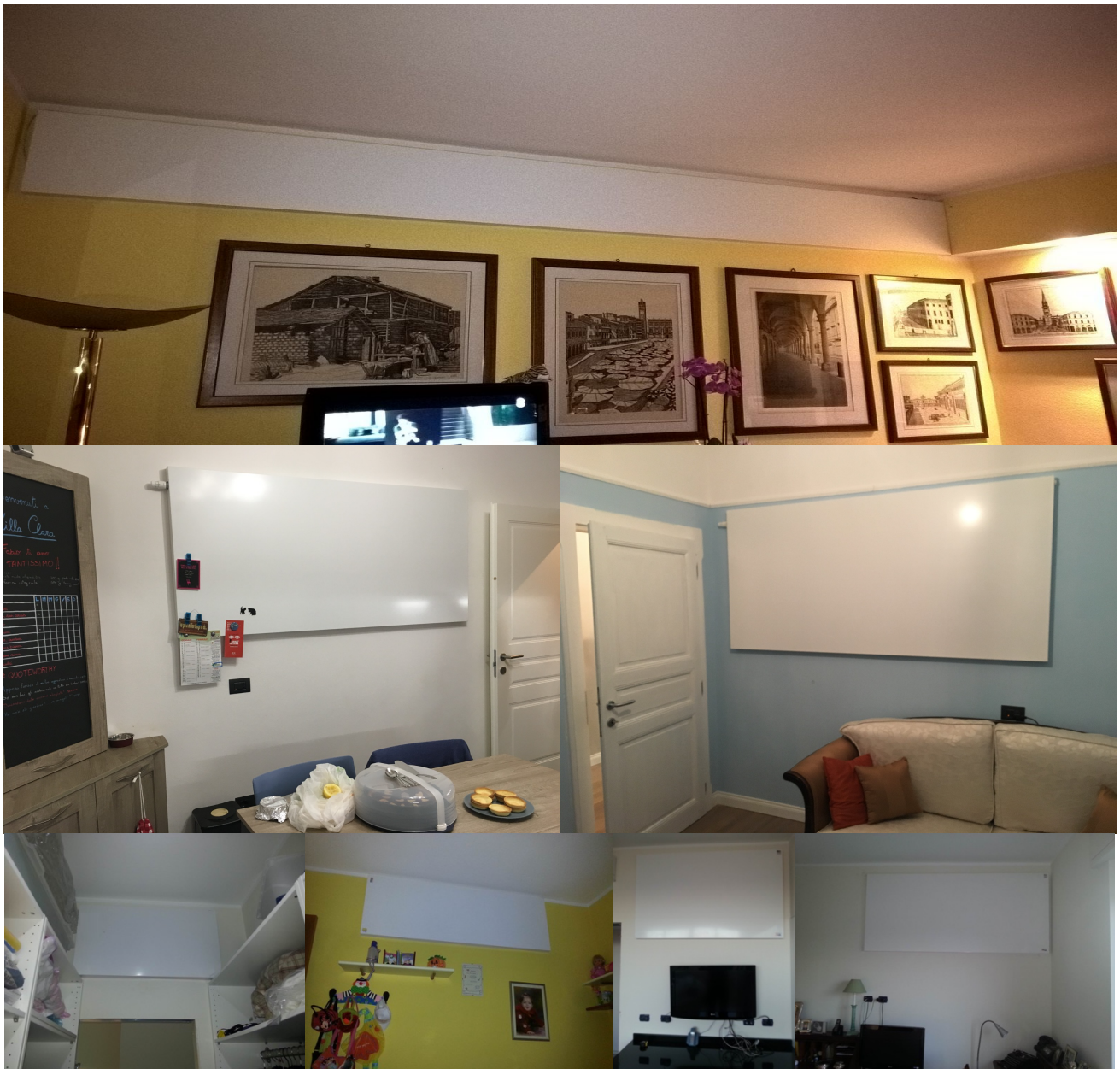
Le piastre radianti VARME KILDEN possono essere installati sia verticalmente che orizzontalmente.
